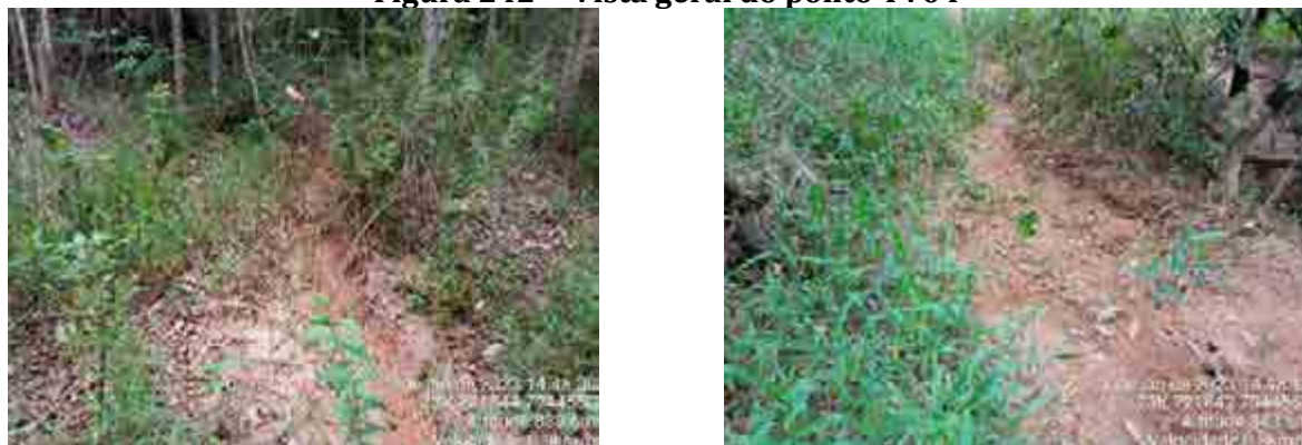
Figura 242 Vista geral do ponto TV04
